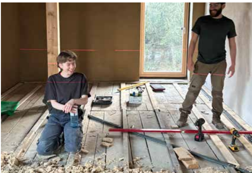
Abb. Reihe 2 Durch kleine Adaptierungen in der Höhe der bestehenden Holzunterkonstruktion kann der Bestandsboden im EG beinahe 1:1 wiederverwendet werden. Die Isolierung ist aus wiederverwendeten Steinwolleplatten
