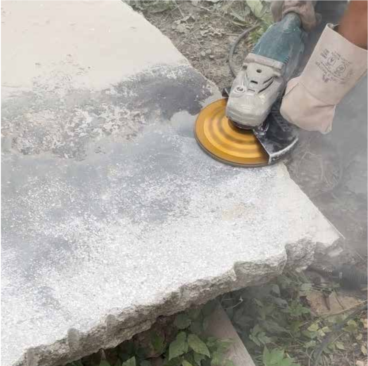
Abb. Schleifen der alten Betonoberflächen der ehemaligen Terrassenplatte, zur Wiederverwendung als Eingangsstufe bei der Kellertür.
