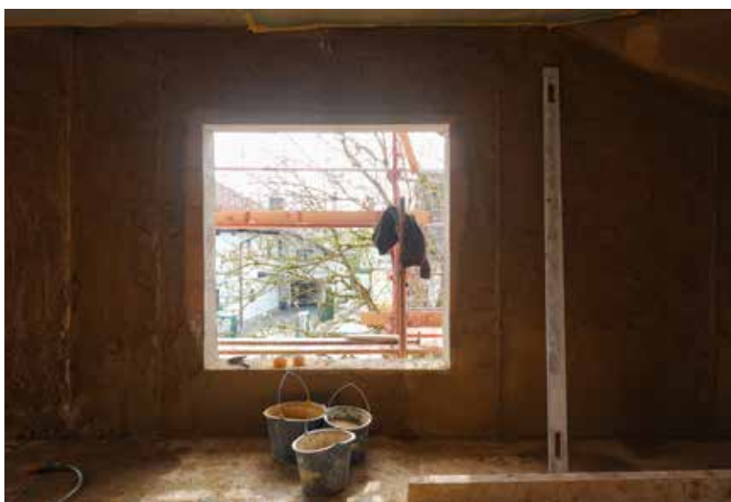
Abb. mitte rechts Anbringen der Putzschienen
