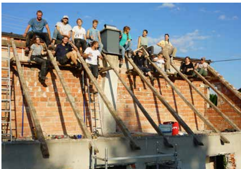
Abb. mitte Das Gebäude verstehen, Materialien ernten und säubern, Bestand skizzieren und den verbleibenden Dachstuhl absichern
